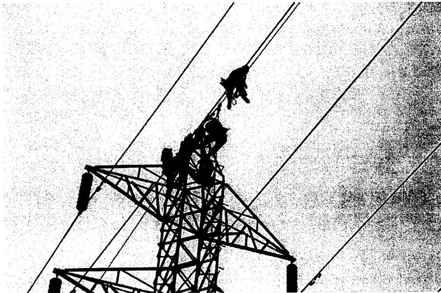
**Cambio del cable de guarda por cable de fibra óptica en L/T Milagro Machala**
