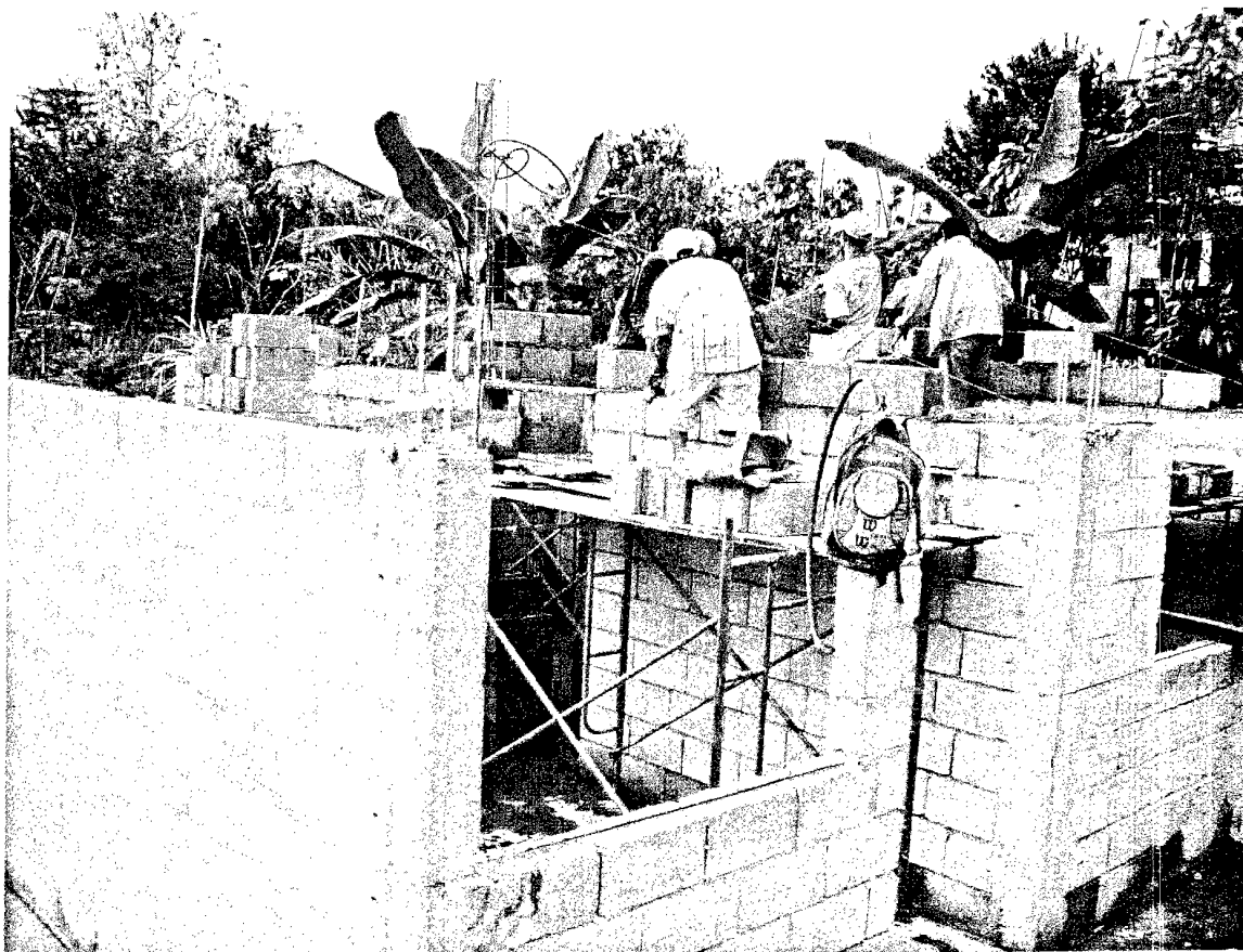
SAN MIGUEL DE LOS BANCOS RECINTO SAN BERNABE. 20 DE SEPTIEMBRE DEL 2008 VIVIENDAS EN CONSTRUCCION.
