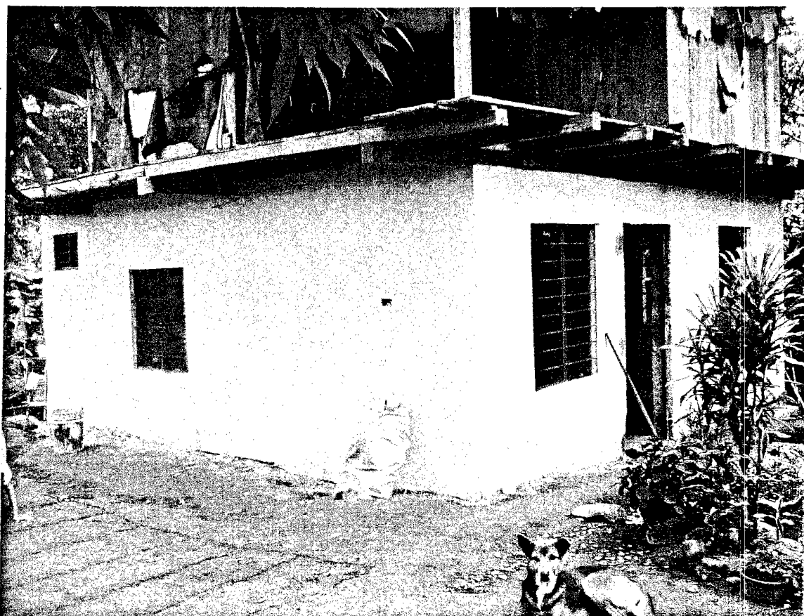
SAN MIGUEL DE LOS BANCOS RECINTO SAN BERNABE. 18 DE OCTUBRE DEL 2008 MEJORAMIENTO DE VIVIENDA DESPUES DE LA INTERVENCION.
