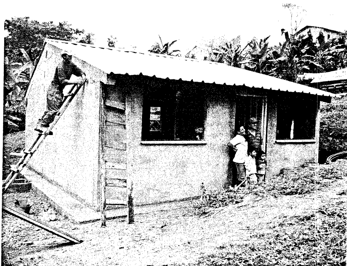
SAN MIGUEL DE LOS BANCOS RECINTO SAN BERNABE. 17 DE OCTUBRE DEL 2008 BENEFICIARIOS DURANTE EL PROCESO CONSTRUCTIVO DE LAS VIVIENDAS.
