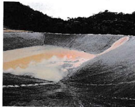
**INSTALACIÓN DE GEOMEMBRANA EN PISCINA No. 11    PISCINA TERMINADA ACTUALMENTE EN USO**
