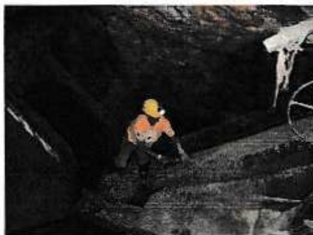
Buzones de descarga en el primer nivel – 10m
