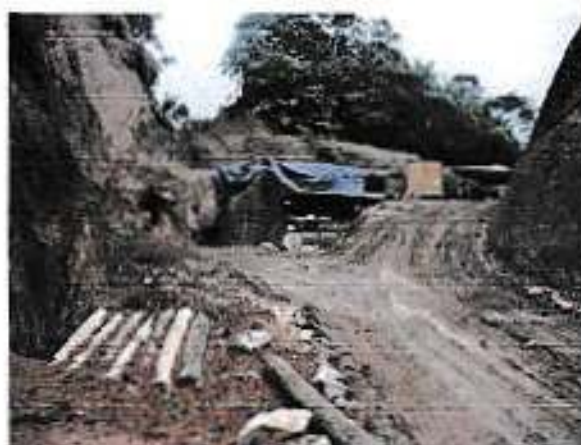
Ingreso pique vertical
