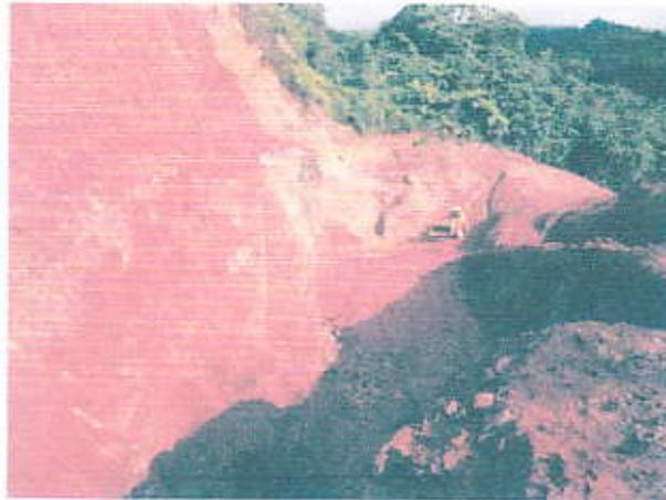
De igual manera y previa aprobación del Directorio de la Compañía, se han realizado trabajos de exploración en la veta del Chirimoyo; su ingreso se realiza a través de un bloque de material meteorizado con presencia permanente de agua y completamente deleznable, por lo que se han presentado varios deslizamientos que no han causado accidentes al personal que labora en ese sector.
