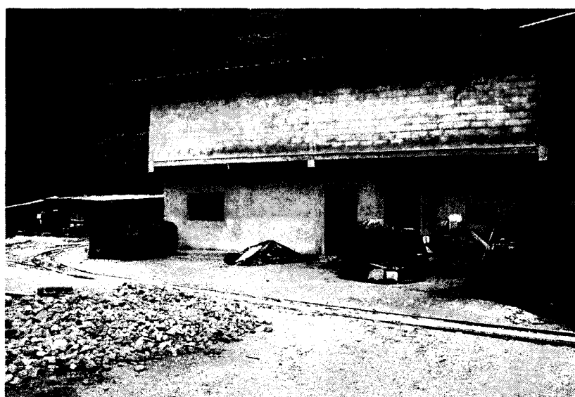
CONSTRUCCIÓN DE BODEGA PRINCIPAL
