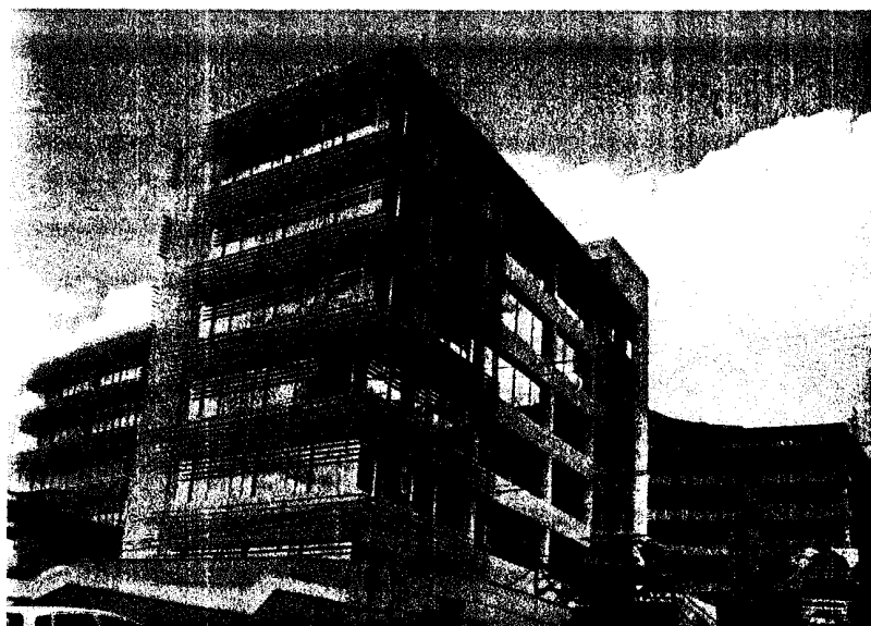
Torre Médica I, totalmente concluida, avance del puente y de la Torre II-III
