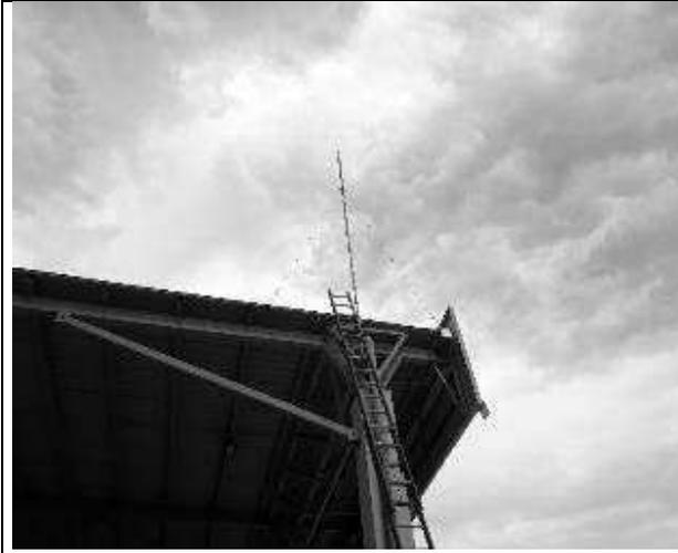
Montaje de pararrayos PDC en cubierta de peaje
