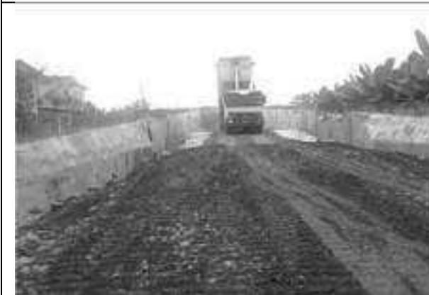
Transporte. Hidratación y compactación de material de mejoramiento en aproches del puente.
