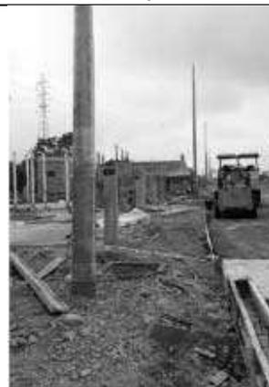
Colocación de postes de alumbrado público de fibra de vidrio en lado derecho
