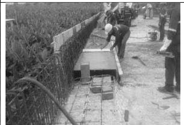
Fundición de losa de paso peatonal de puente a desnivel .
