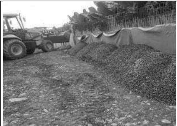
Colocación de material filtrante en pared de muros.
