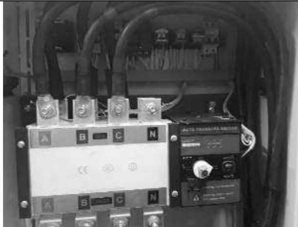
Instalación y montaje de transferencia motorizada para generador eléctrico
