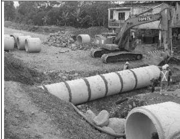
Prolongación de Tubería de Hormigón Armado
