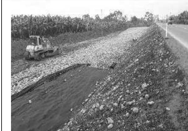
Colocación de Geotextial y Geomalla Biaxial
