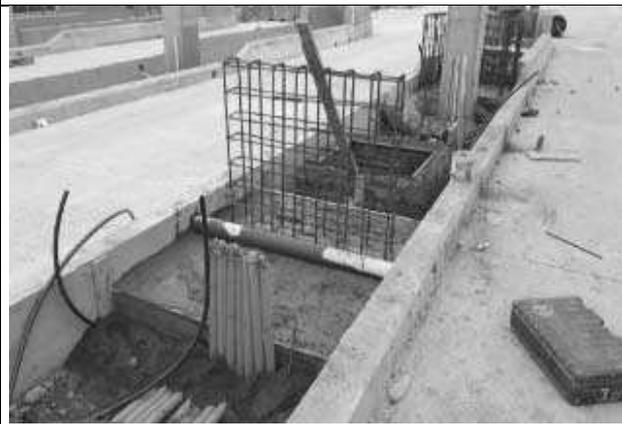
Hormigonado de muro de protección en carriles de peaje
