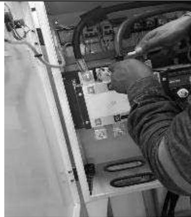
Instalación y montaje de transferencia motorizada para generador eléctrico
