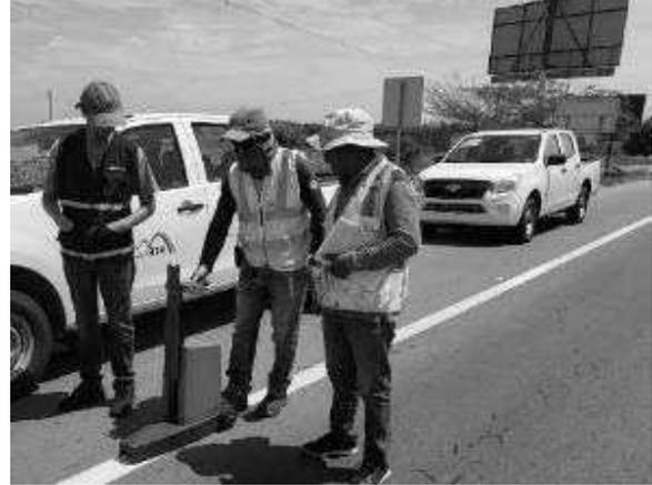
Aplicación de señalización horizontal y control de calidad de retroreflectividad Tramo Chacras - Huaquillas
