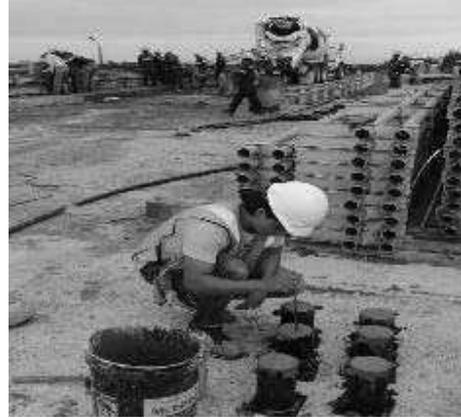
Toma de cilindros de hormigón para ensayos de control de calidad.
