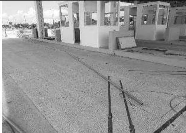
Colocación de tuberías para la protección de cable 2/0 AWG para la bajante del sistema de protección atmosférica, pararrayos PDC.
