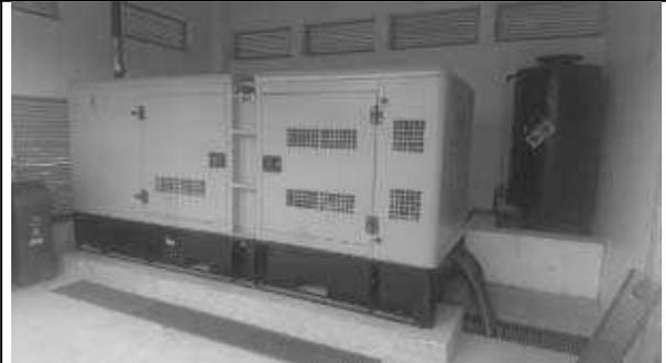
Instalación de generador eléctrico 125kVA/220/127V.
