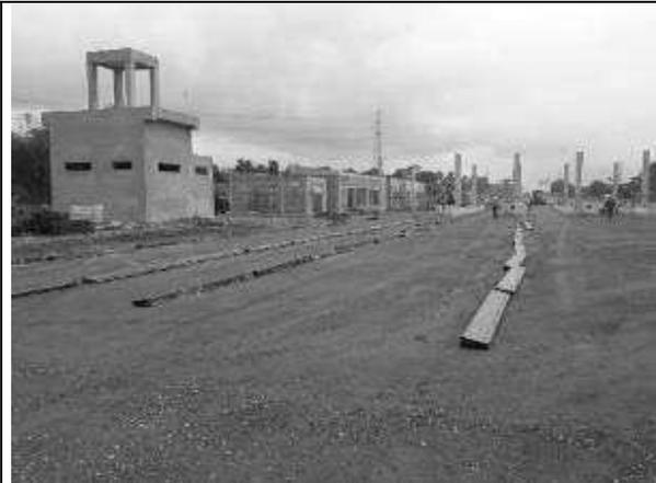
Encofrado para fundición de pavimento Rígido
