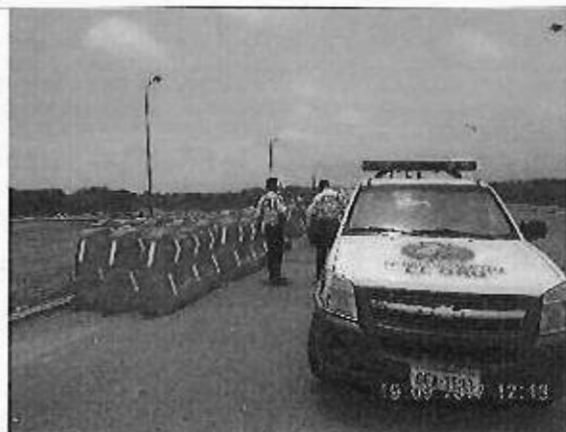
Colocación de canalizadores de tráfico en el intercambiador de bella india con el fin de prevenir accidentes de tránsito
