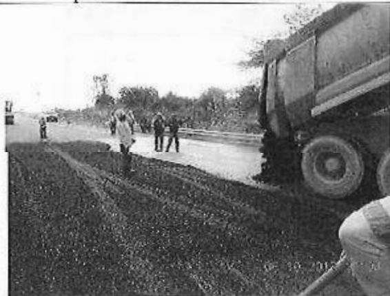
Bacheos y nivelaciones en todo el proyecto Río Siete – Huaquillas, solicitado por el fiscalizador.
