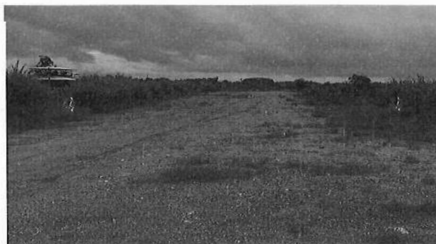
Estado actual del tramo 27+600
