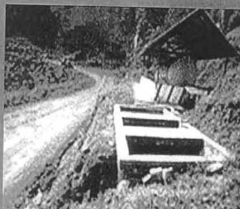
Trabajos de construcción de acceso a la parte alta por el frente norte y construcción del polvorín
