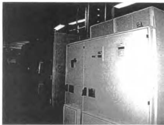
Instalación del nuevo sistema de accionamiento del ventilador G38
