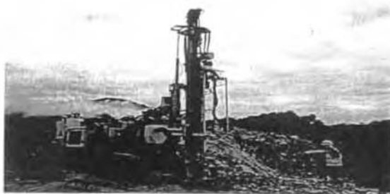
Trabajos de perforación
