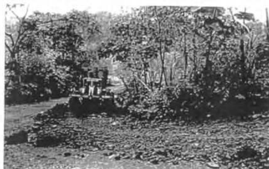
Trabajos de limpieza de cunetas en la vía
