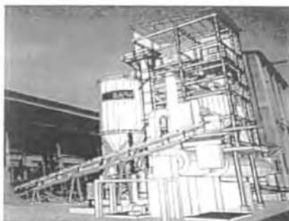
COORDINACIÓN Y FISCALIZACIÓN DE OBRA CIVIL DE PREMOLIENDA Y SECADOR DE PUZOLANA
