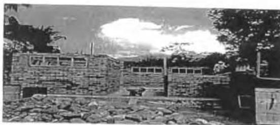
Trabajos de construcción de acceso a la parte alta por el frente norte y construcción del polvorín
