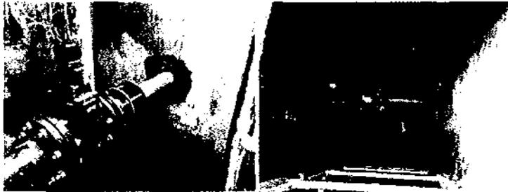
Se procedió a realizar la conexión de la T de la tubería macro de 400mm de Eapa San Mateo, hacia nuestra tubería ubicada en la Cumbia.
