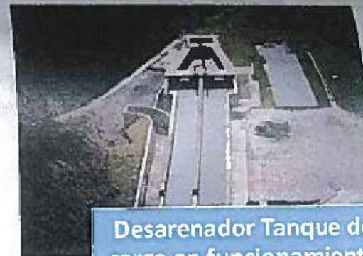
Desarenador Tanque de carga en funcionamiento
