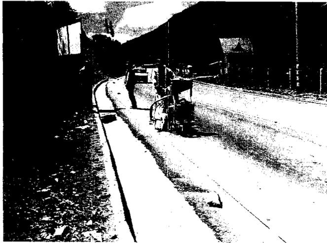
**Foto No. 04** Señalización horizontal, pintura del eje y líneas laterales de la vía.
