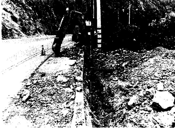
**Foto No. 15** Trabajos de excavación para tendido de tubería (matriz) en la construcción del sistema de agua potable para la comunidad Primosol.
