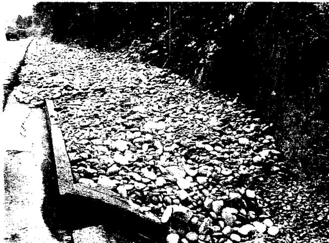
**Foto No. 17.** Construcción de subdrenes en tramos de vía que evidencian deterioro (Descanso-Lumagpamba y Lumagpamba-Paute).
