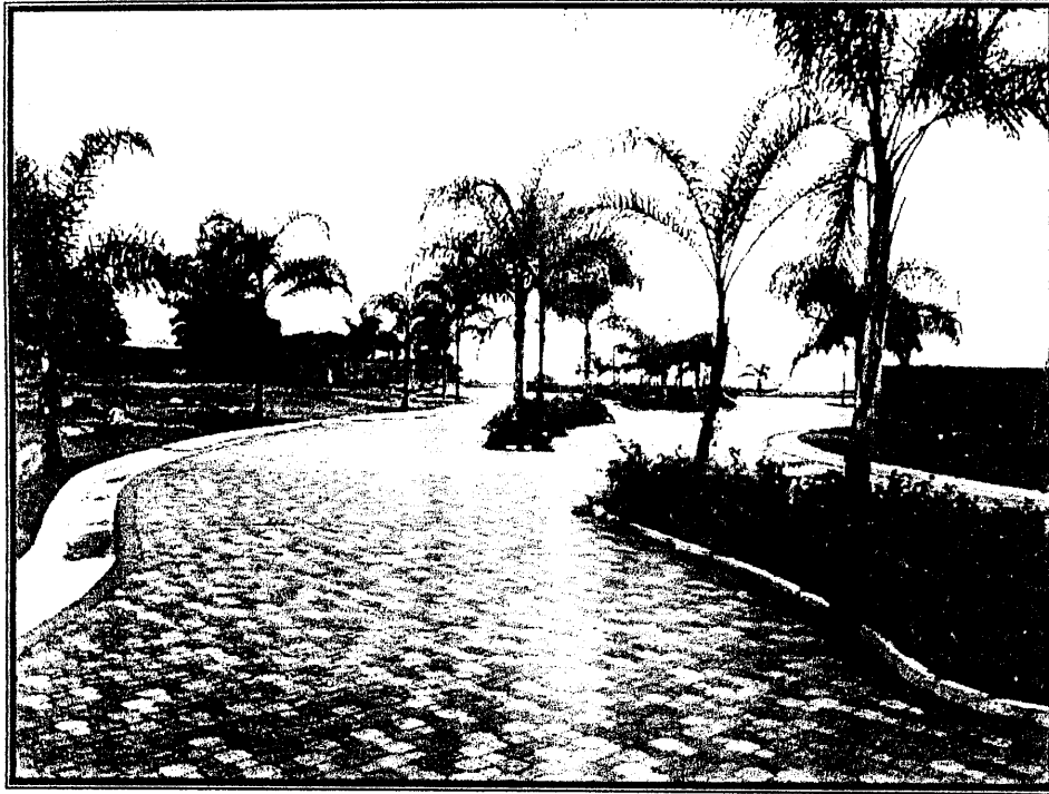
Foto 1: Vista exterior de calle de lotización
