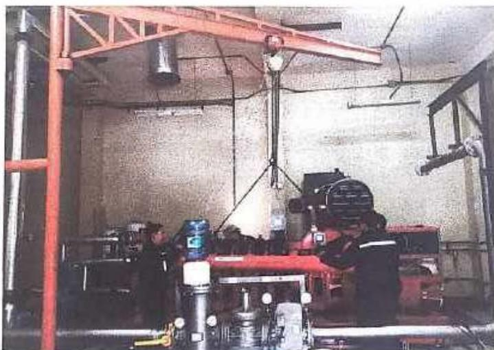
*Imagen 2. Brazo grúa instalado en la casa de máquinas del proyecto Pichacay.*
