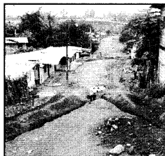
Los moradores construyen la canalización de aguas lluvias.
