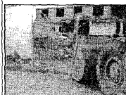
Remoción de escombros del antiguo cuartel de Policía.
