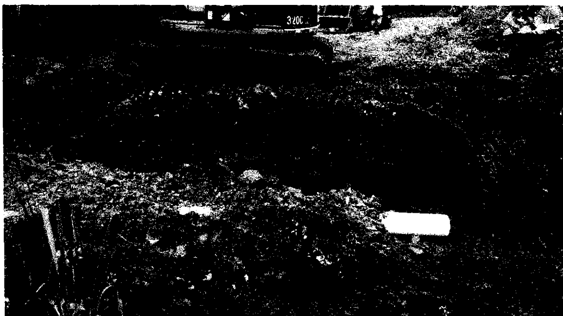
Colocación de alcantarillas plásticas, en reemplazo de los palos huecos normalmente utilizados, plantación1
