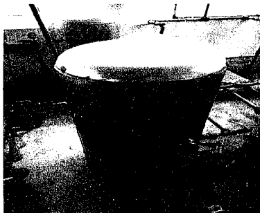
Tanque de presión con sus respectivas piezas sanitarias
