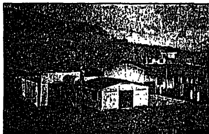
CASA DE MAQUINAS
